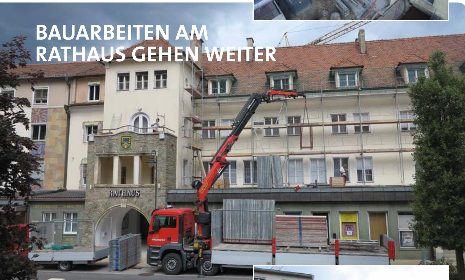
Nach der Corona-bedingten Zwangspause sind die Bauarbeiten beim Rathaus wieder voll angelaufen. Derzeit wird an der grabenstraßenseitigen Rampenanlage gearbeitet, die vor der Fertigstellung steht. Dann kann das Rathaus eingerüstet und mit den Dachsanierungsarbeiten und in weiterer Folge mit den Fassadenarbeiten samt Fenstertausch begonnen werden. Hauptplatzseitig steht das Gerüst bereits.
